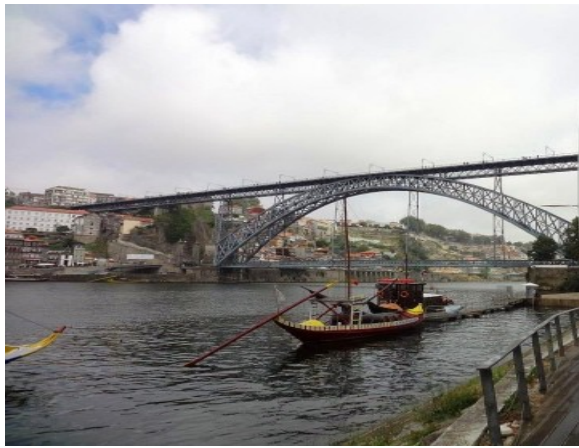
Eiserne Bogenbrücke Ponte Dom Luis I
