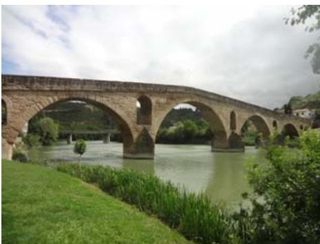
Brücke mit seinen 6 Bögen, 11. Jh.
