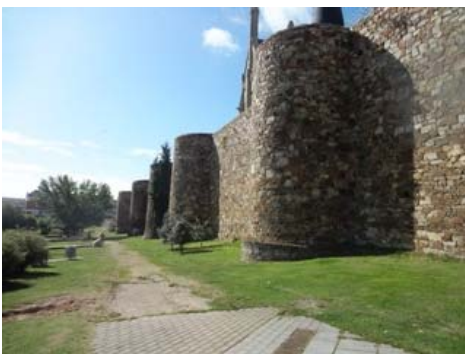
Astorga, römische Stadtmauer
