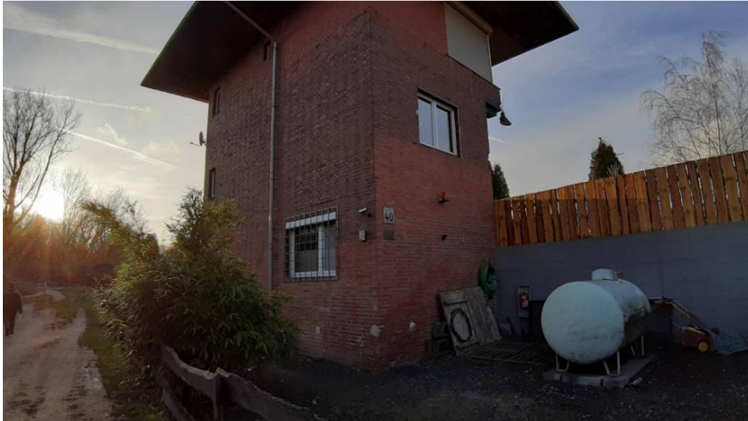
Ehemaliges Stellwerk von Victor III/IV
