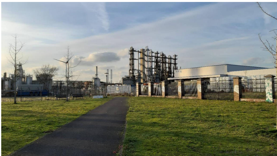
Blick auf die Raffinerie für Steinkohlenteer von Rütgers Germany (Rain Carbon)
