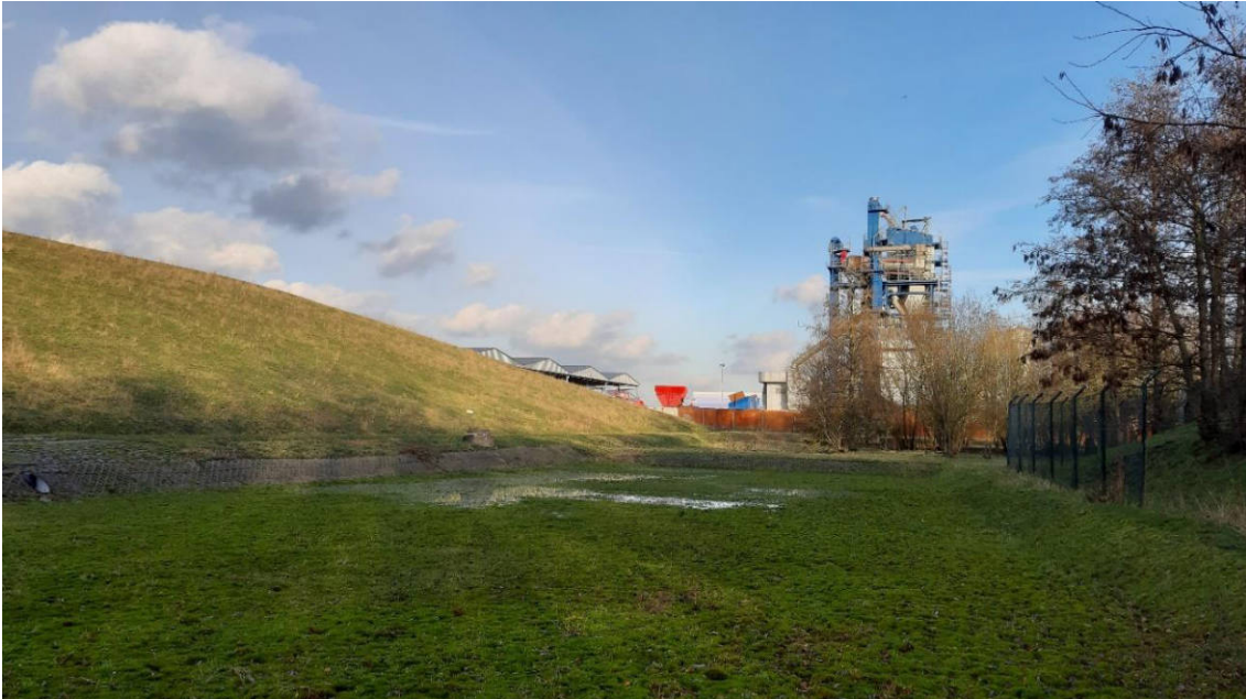
Das Emschermischwerk (Eiffage Infra-Asphalt GmbH)
