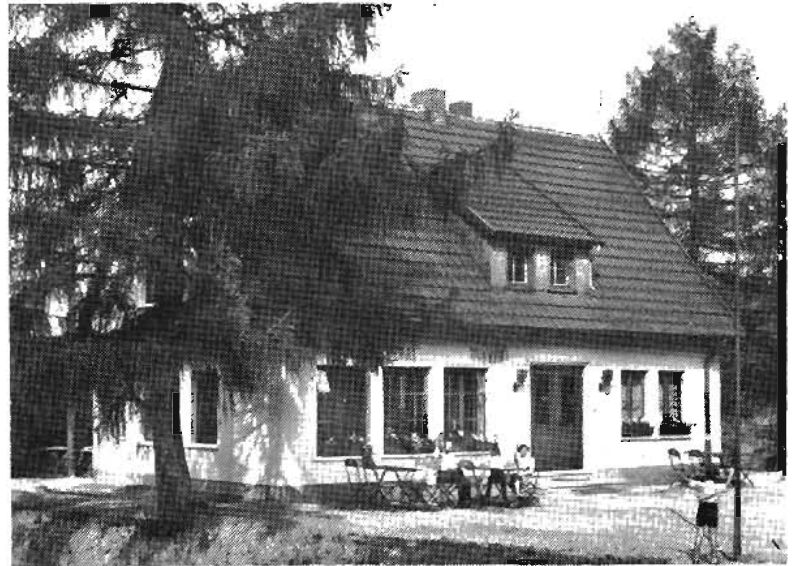
Das SGV-Heim nach seiner Fertigstellung
