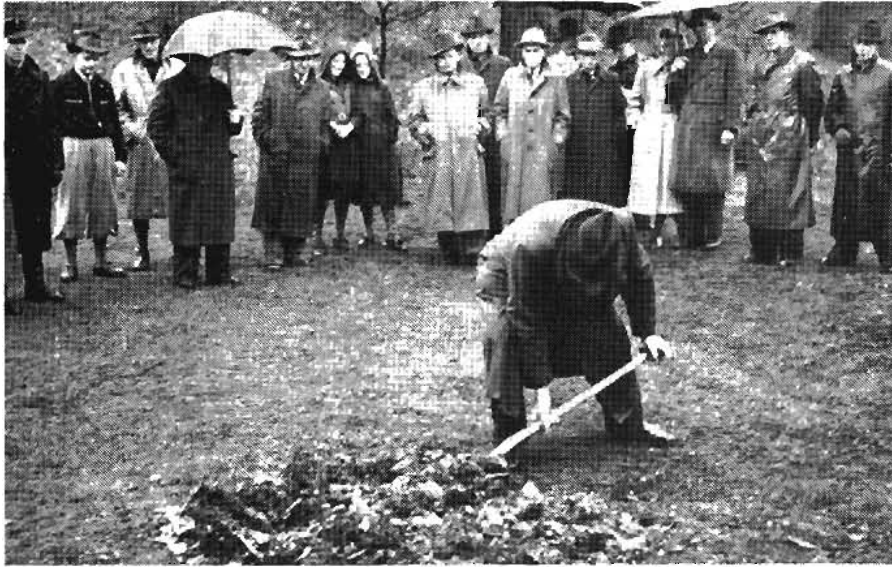
1. Spatenstich zum Heim an der Schwerter Straße
