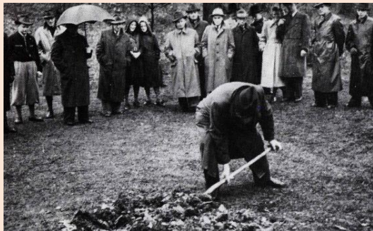
Der erste Spatenstich am 07.04.1951
