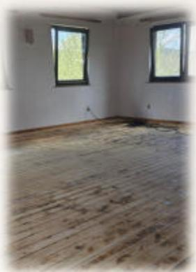
Im Jahr 2025 wurde der Echtholzboden der SGV-Hütte umfassend saniert. Der über viele Jahre hinweg gedunkelte und stark abgenutzte Boden wurde von fleißigen Helferinnen und Helfern sorgfältig abgeschliffen und anschließend neu gestrichen.
